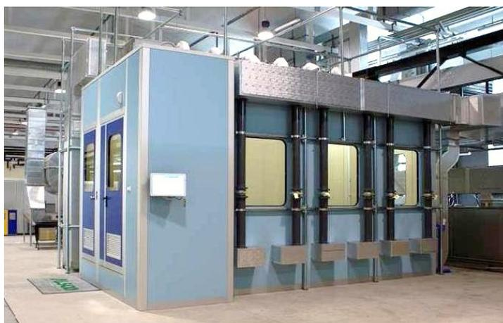
La camera può essere a pressione negativa o positiva rispetto all'ambiente in cui si trova. L'impiantistica è interamente gestita da un sistema DDC Direct Digital Control. Trattandosi di un mini
